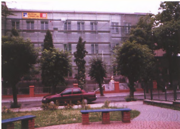
V – VII prace remontowe
