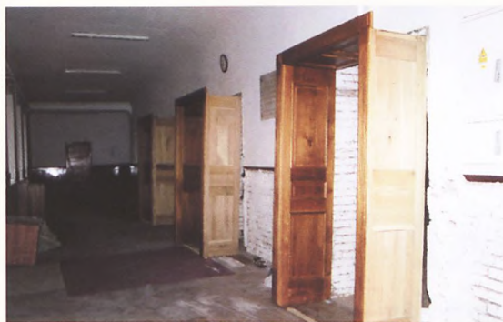
Montaż drzwi do auli
