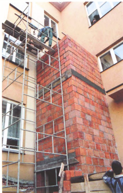
Prace związane z budową windy w Naszym Liceum
