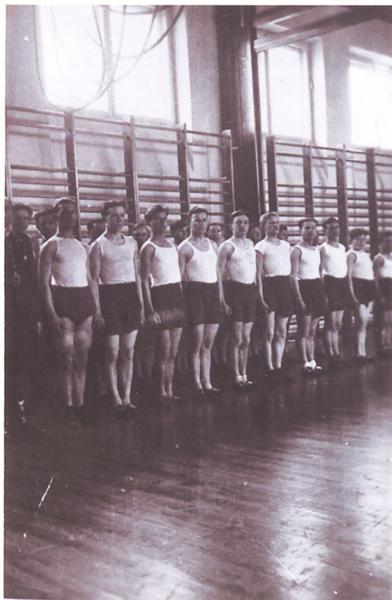
Wychowanie fizyczne w nowej sali gimnastycznej. Dwie belki zawieszono pod sufitem to tram (przrządk gimnastyczny)
