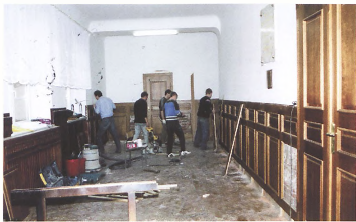
Zakładanie boazerii na I piętrze
