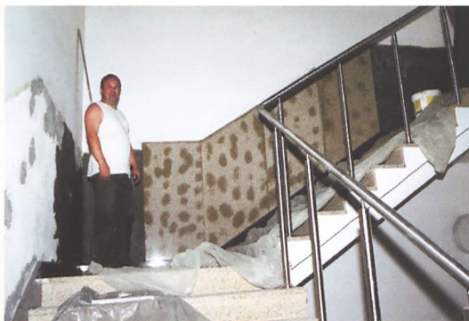
Zakładanie granitowej boazerii
