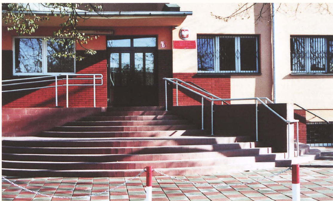
Schody budynku B po remoncie
