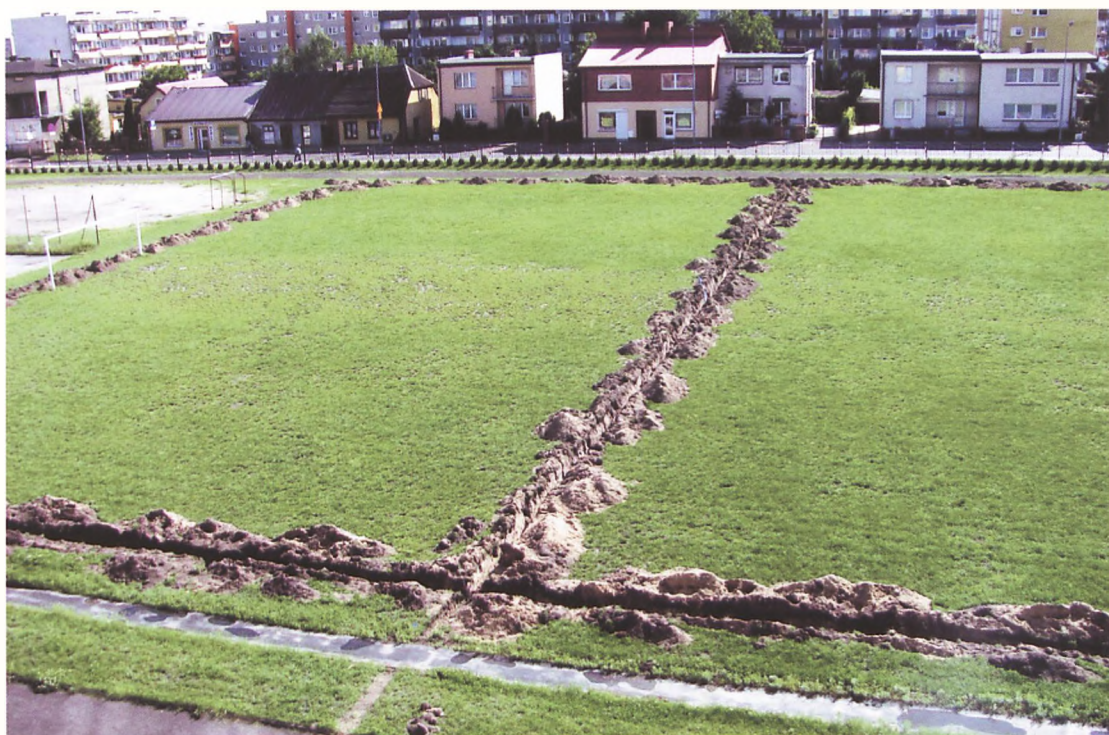
Budowa systemu nawadniającego boisko
