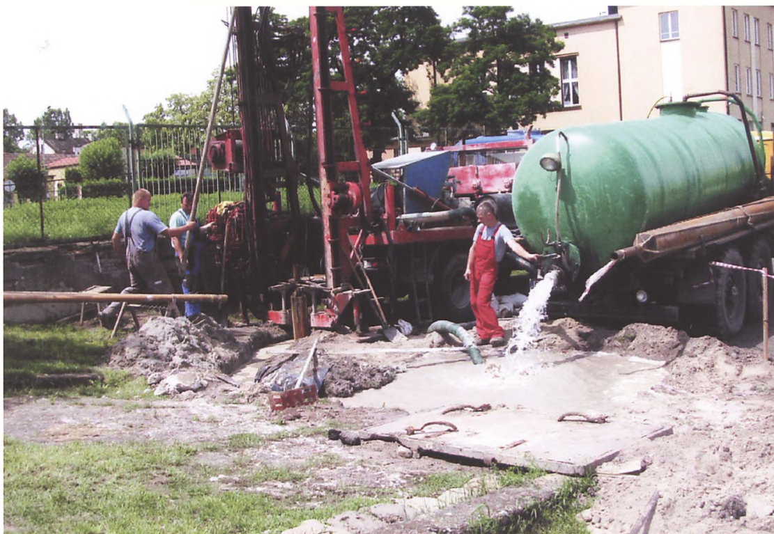
Wiercenie studni głębinowej
