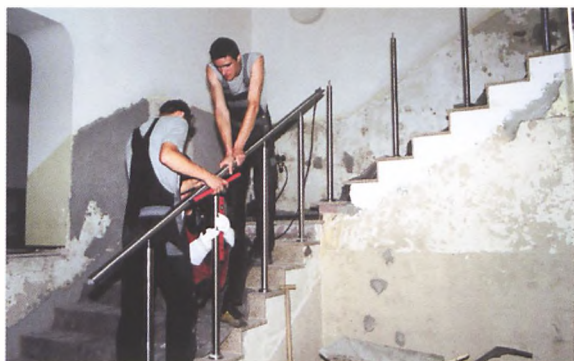
Remont schodów głównych
