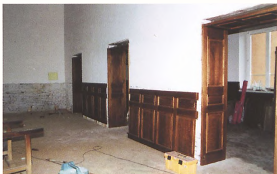
Montowanie boazerii w auli
