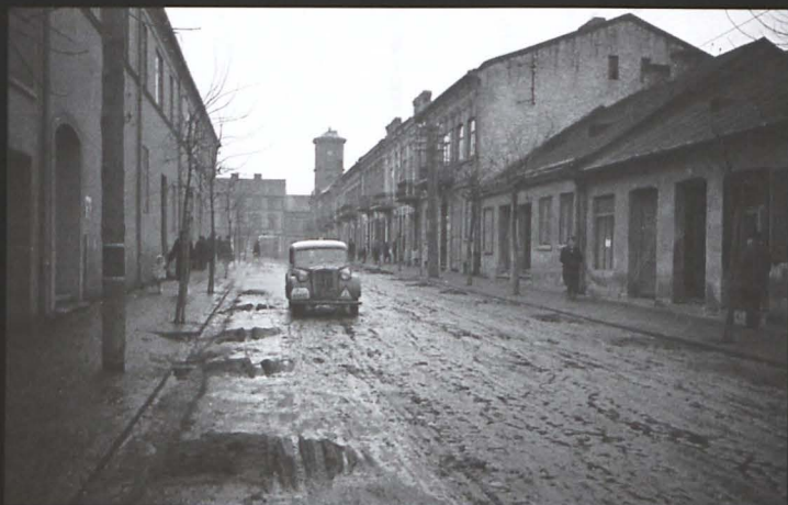
Turek - marzec 1942 r. Wärthbrückener Straße , obecnie ul. Kolska, widok w kierunku rynku. Nawet brukowane ulice miasta podczas roztopów nie wyglądały zbyt dobrze.
