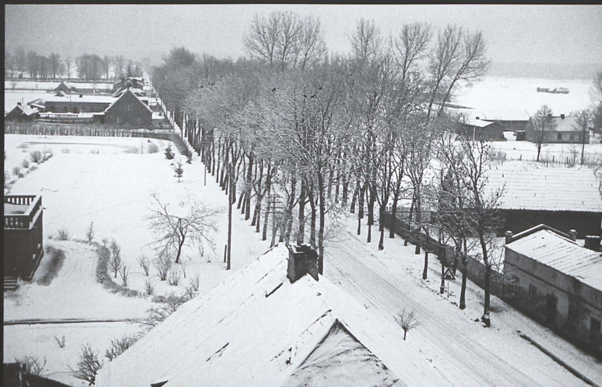
Turek - luty 1942 r. Widok na Landratsallee , obecnie ul. F. Chopina z budynku Oberschule - Szkoły Podstawowej nr 1 w kierunku miejscowości Władysławów.
