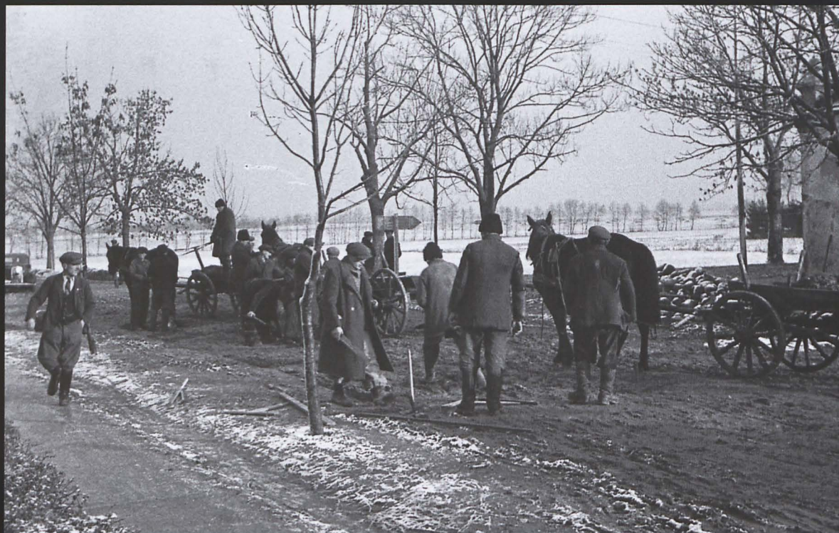
Kowale Pańskie - 10 listopada 1941 r. Budowa drogi w kierunku miejscowości Dobra.
