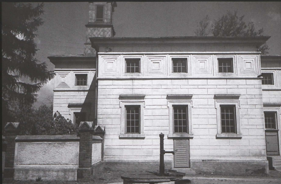
Turek - maj 1942 r. Kościół ewangelicki i podwórkó pastorówki z pompą. Widok od strony południowej.
