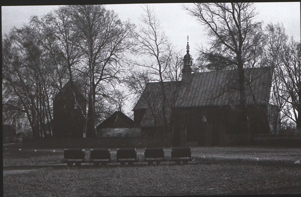
Pęczniew - 9 listopada 1941 r. Zabytkowy kościół parafialny o konstrukcji drewnianej.
