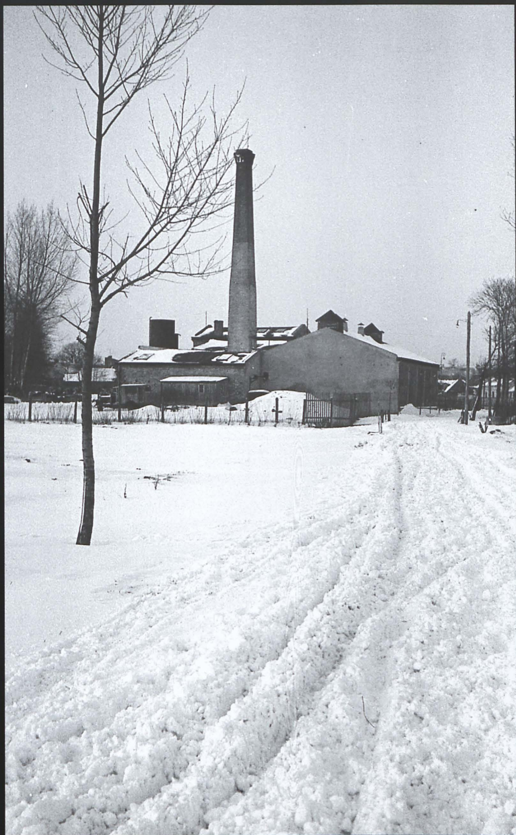
Turek - luty 1942 r. Parkstraße , obecnie ul. Gorzelniana z budynkiem dawnej gorzelni.
