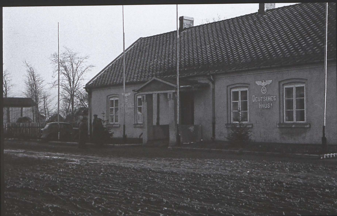
Goszezanów - 9 listopada 1941 r. Deutsches Haus - Dom Niemiecki, obecnie budynek plebanii.
