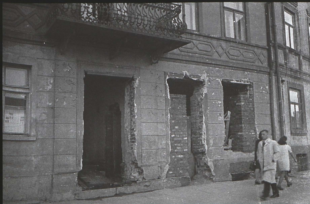
Turek - maj 1942 r. Prace budowlane w jednej z kamienic pierzei zachodniej na Adolf Hitler Platz ; obecnie Plac Wojska Polskiego.
