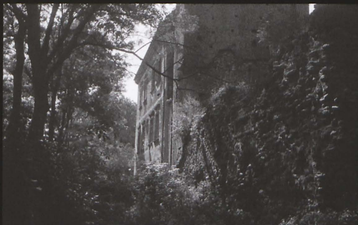
Uniejów - sierpień 1942 r. Wschodnia fasada zamkowa z widocznymi zniszczeniami po działaniach wojennych 1939 roku.
