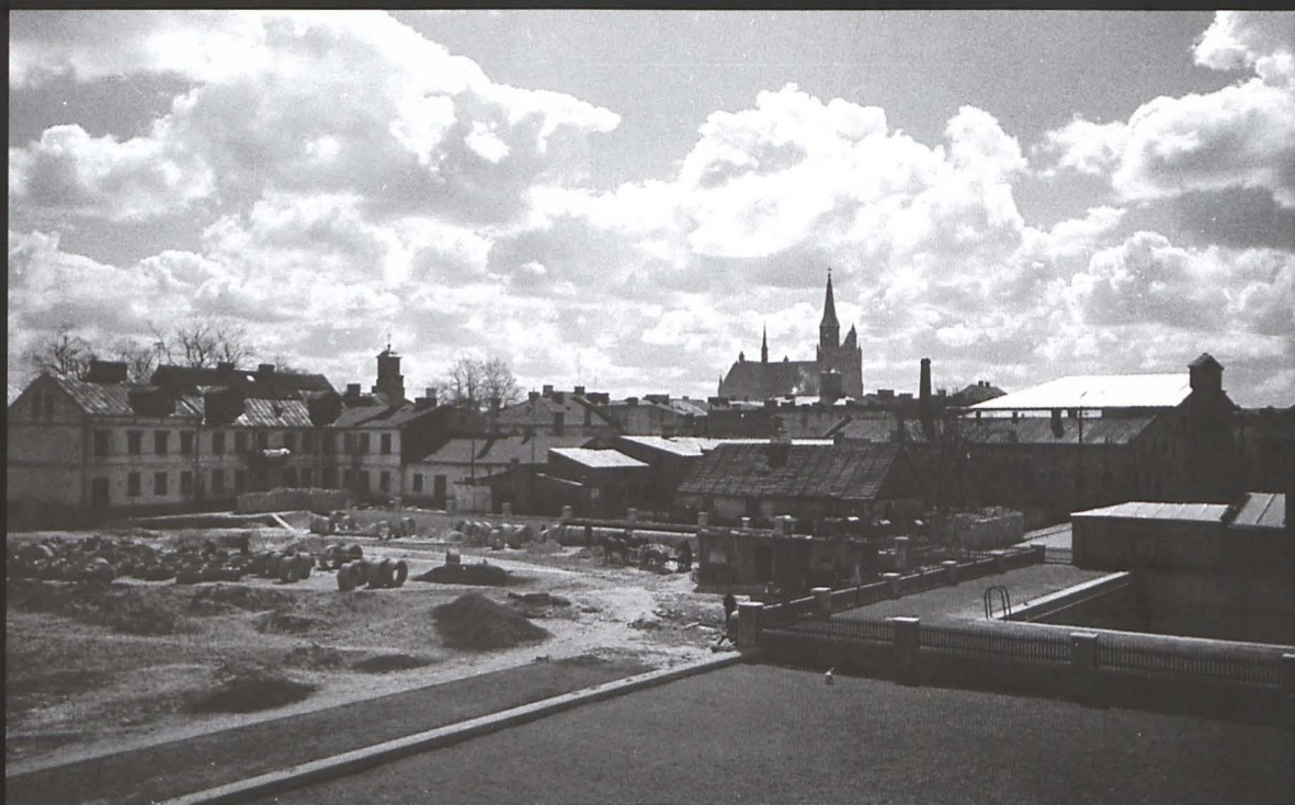
Turek - 29 kwietnia 1942 r. Prace przy budowie strzelnicy na terenie boiska sportowego przy Heim Oberschule , obecnie Zespół Szkół Ogólnokształcących.
