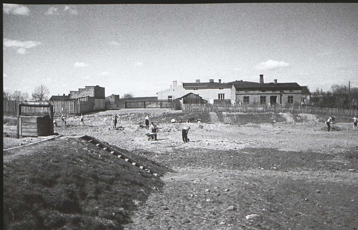
Turek - maj 1942 r. Prace ziemne wykonywane były przez młodych Niemców. Ich celem było uporządkowanie placu pod planowany w tym miejscu Park.
