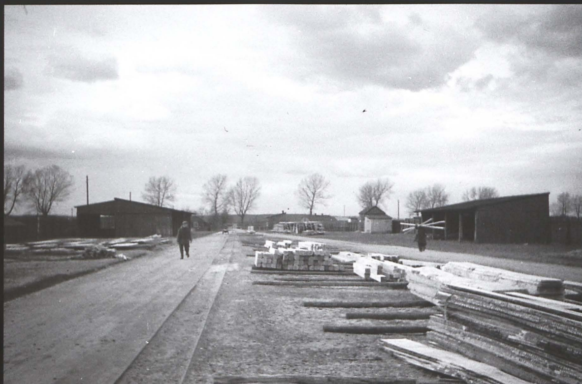
Turek - 30 kwietnia 1942 r. Tartak Zahna przy Warthbrückener Straße , obecnie ul. Kolska Szosa.
