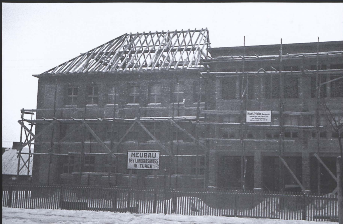
Turek - styczeń 1942 r. Budowa nowego gmachu starostwa - Landratsamt, Straße des 13. September , obecnie ul. Kaliska.
