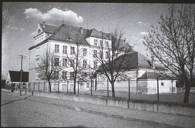
Turek - maj 1942 r. Mühlen Straße , obecnie ul. Kączkowskiego. Budynek Oberschule - Szkoła Podstawowa nr 1 od strony północno - zachodniej.
