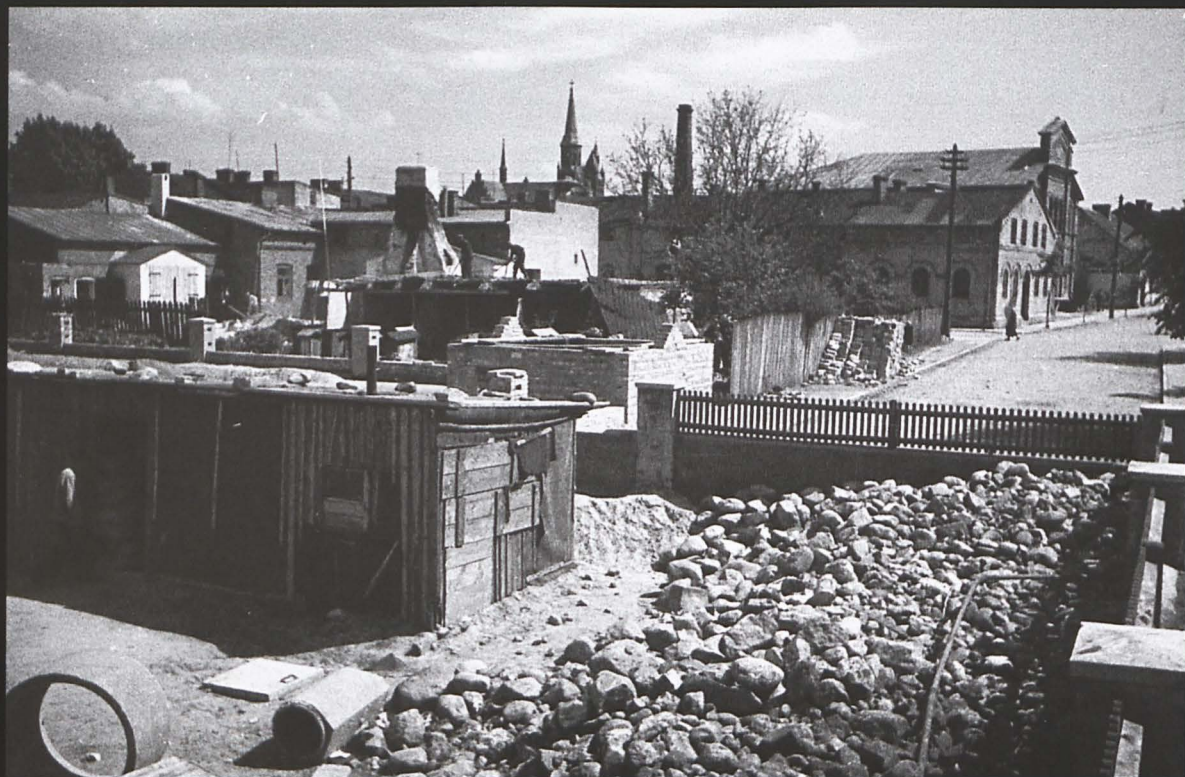
Turek - maj 1942 r. Budowa strzelnicy przy Sportplatz - boisko sportowe Heim Oberschule - Liceum Ogólnokształcące. W tle widoczna panorama Juden Straße , obecnie ul. Szeroka z budynkiem gminy żydowskiej i synagoga.
