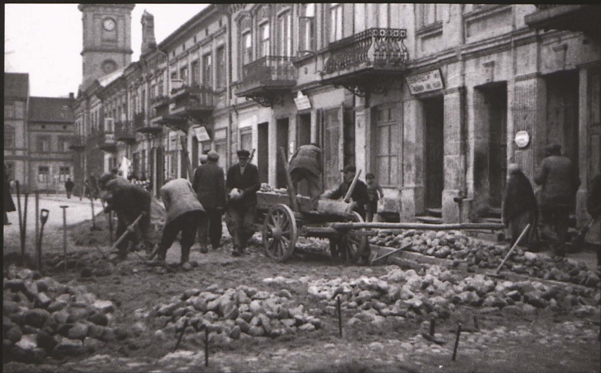
Turek - październik 1941 r. Warthbrückener Straße , obecnie ul. Kolska. Prace brukarskie wykonywane przez mieszkańców Turku pod nadzorem władz okupacyjnych. Widok w kierunku rynku.
