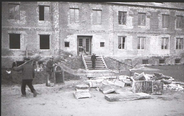
Turek - 29 lub 30 kwietnia 1942 r. Prace budowlane przy budynku Reichsarbeitsdienst Gruppe 400 - Służba Pracy Rzeszy Grupa 400. Uwagę zwraca wykorzystanie macew - żydowskich nagrobków - do wznoszenia schodów.
