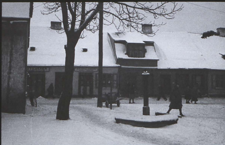
Turek - styczeń 1942 r. Fragment Straße des 13. September ; obecnie ul. Kaliska. Zdjęcie wykonane od strony Juden Straße , obecnie ul. Szeroka.
