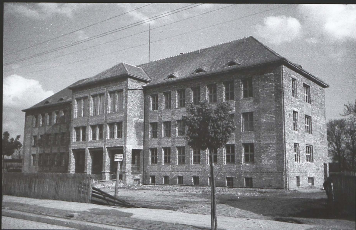
Turek - maj 1942 r. Budowa nowego obiektu Landratsamt - starostwa przy Straße des 13. September ; obecnie ul. Kaliska.
