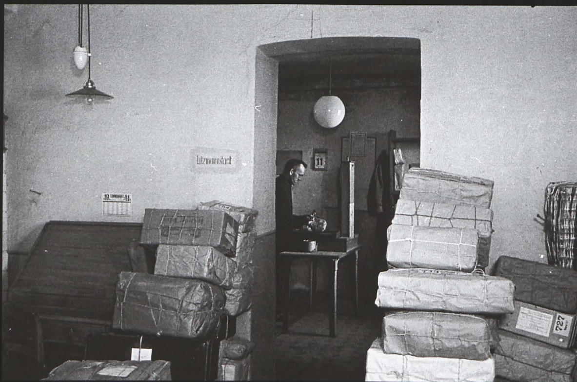
Turek - maj 1942 r. Postamt - Urząd Pocztowy przy Straße des 13. September ; obecnie ul. Kaliska. Magazyn przesyłek pocztowych.
