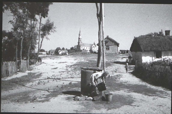
Tuliszaków - 20 sierpnia 1942 r. Czerpanie wody ze studni. Na uwagę zasługują niespotykane już dzisiaj zabudowania, jak gliniane chaty kryte strzechą. W oddali widoczny kościół parafialny.
