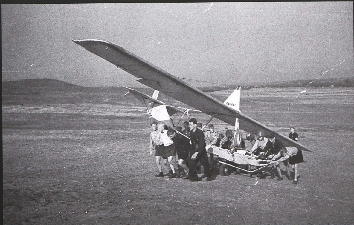
Turek - sierpień 1942 r. Wprowadzanie szybowca na szczyt wzniesienia, na specjalnie do tego celu przygotowanym wózku.
