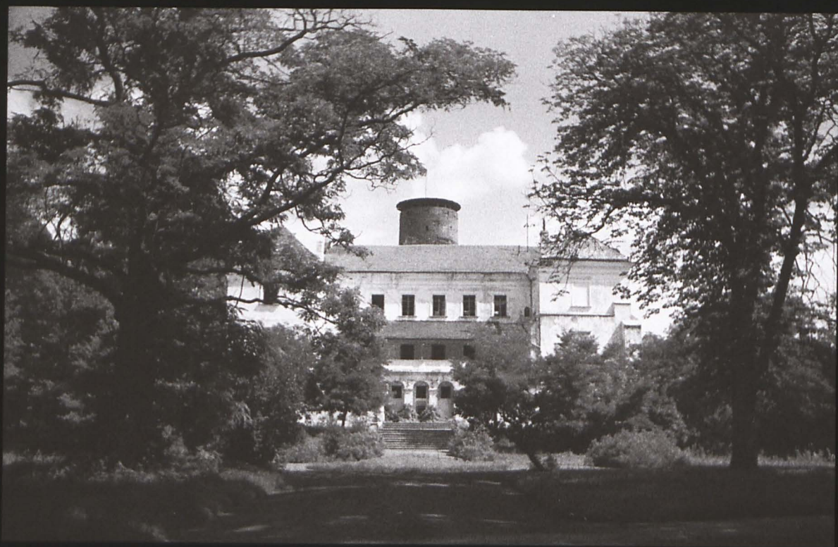
Uniejów - sierpień 1942 r. Widok na zamek z terenu parku - elewacja zachodnia.
