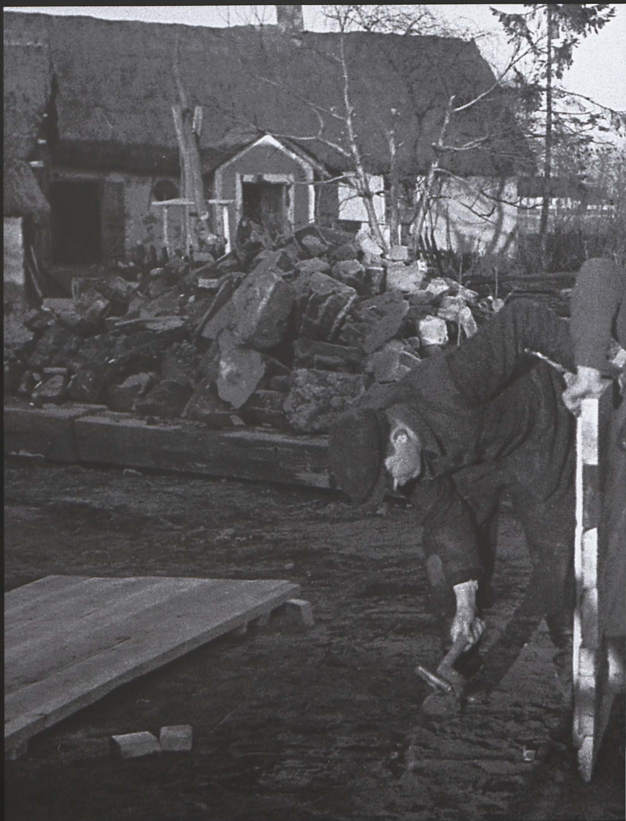
Przykona - 10 listopada 1941 r. Prace rozbiórkowe na terenie jednego z gospodarstw. W oddali widoczny kościół parafialny w Psarach.
