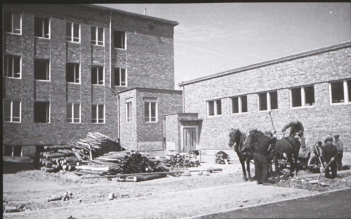
Turek - kwiecień 1942 r. Budynek Heim Oberschule - Wyższej Szkoły Ojczyznianej od strony boiska. Skład surowca do budowy plotu stadionowego przy N.S.K.K. Straße , obecnie ul. 3 Maja.
