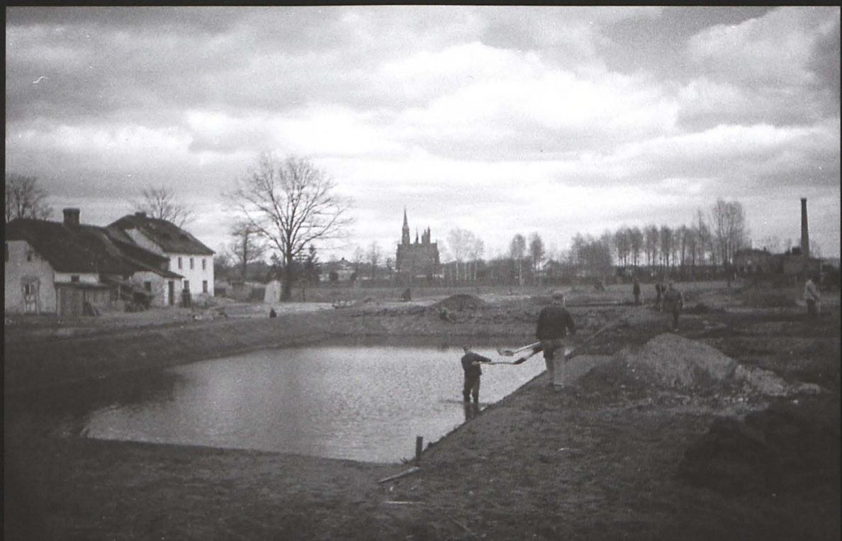
Turek - 27 kwietnia 1942 r. Budowa stawu oraz parku za budynkiem nowego Landratsamt przy Straße des 13. September ; obecnie ul. Kaliska. Z prawej strony widoczne zabudowania gorzelni.
