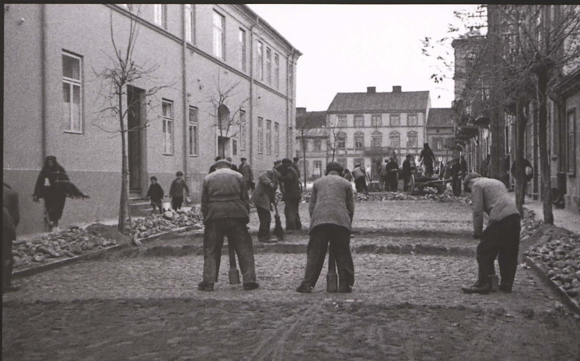
Turek - październik 1941 r. Warthbrückener Straße , obecnie ul. Kolska. Prace brukarskie wykonywane przez mieszkańców Turku pod nadzorem władz okupacyjnych.
