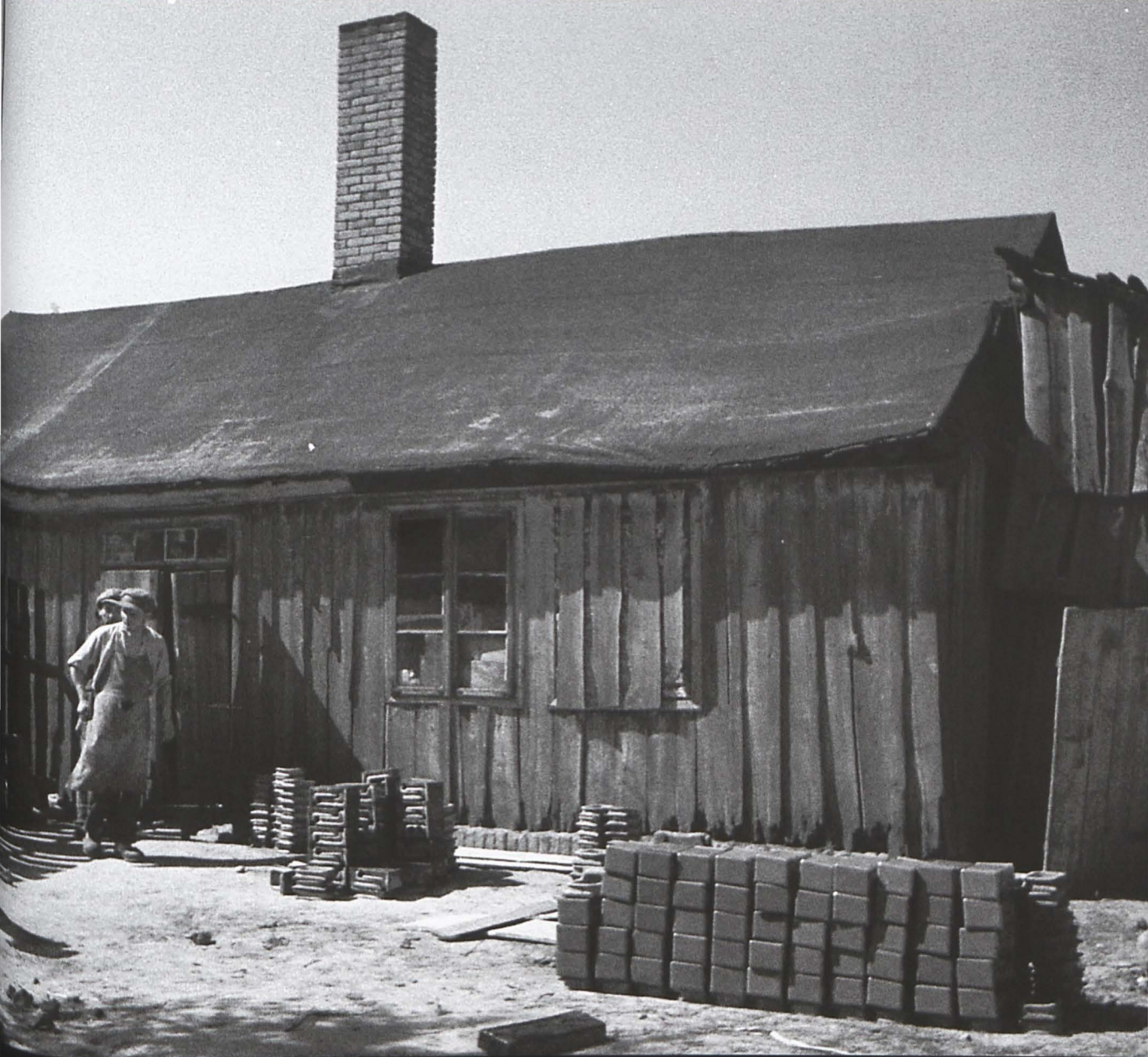
Tulisków - 20 sierpnia 1942 r. Suszenie kafli. Z prawej strony widoczne formy.
