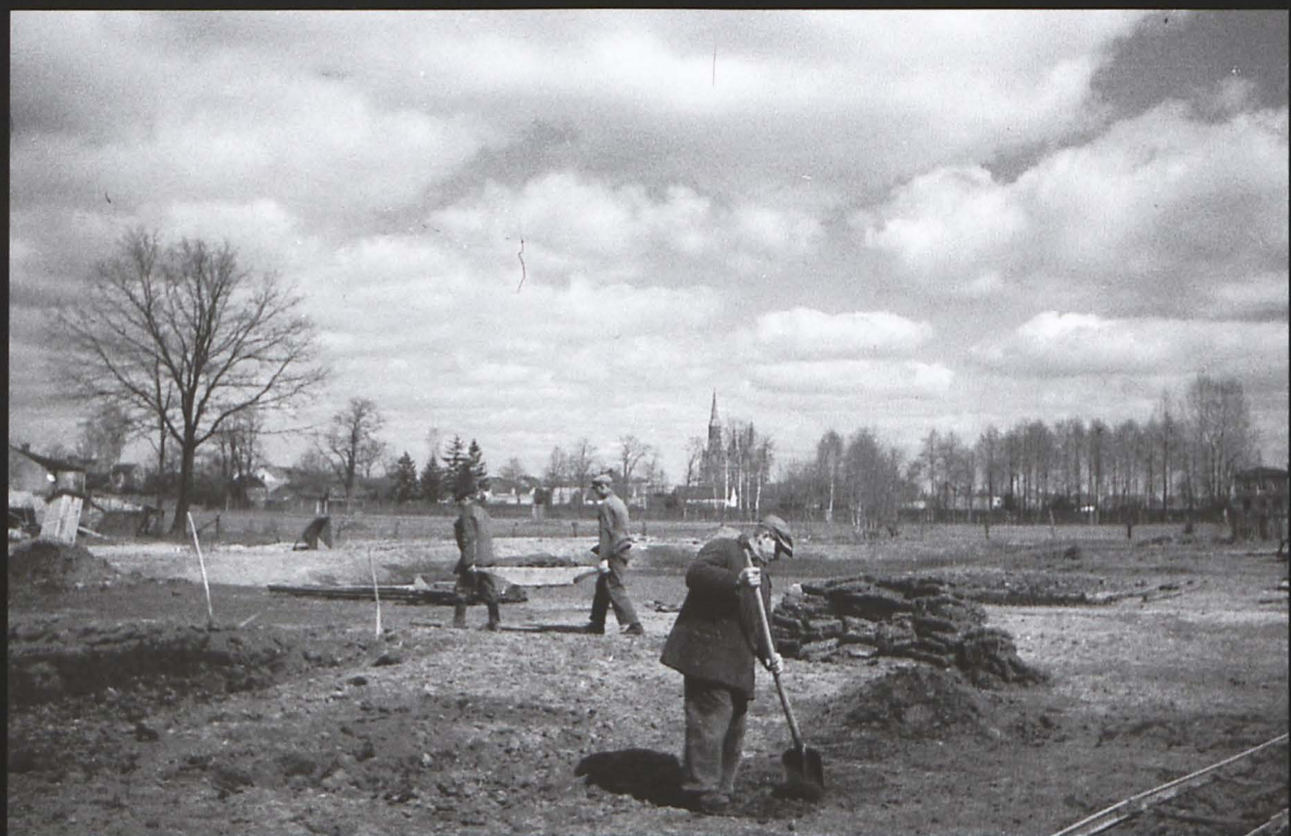
Turek - 27 kwietnia 1942 r. Prace ziemne wykonywane przez Polaków przy budowie parku i stawu z tyłu budynku Landratsamt przy Straße des 13. September ; obecnie Urząd Miejski przy ul. Kaliskiej.
