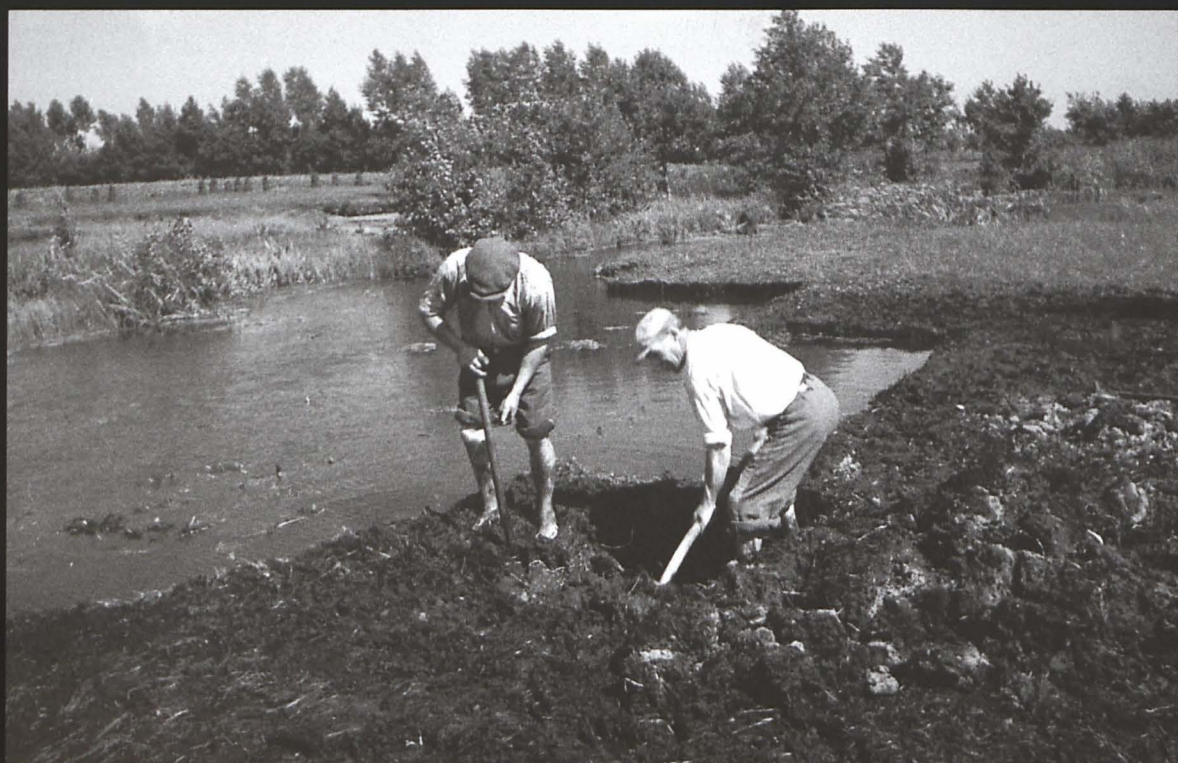
Tulisków - 20 sierpnia 1942 r. Prace przy kopaniu torfu.
