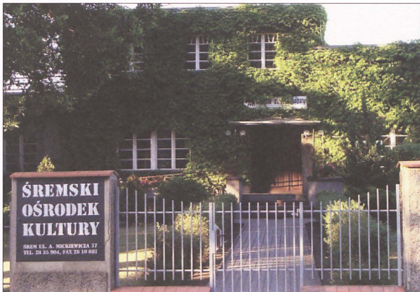
196. Budynek Śremskiego Ośrodka Kultury przy ul. Mickiewicza 77 (2012 rok)
