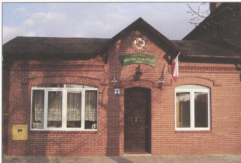
215. Odrestaurowana część fasady budynku brackiego. (Zbiory autora)
