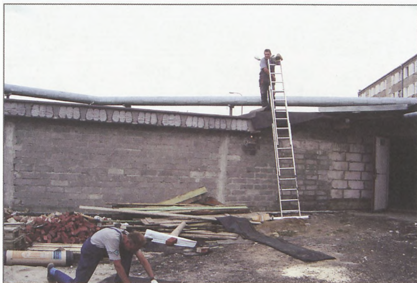
216. Prace wykończeniowe pokrycia dachu na strzelnicy 25 m. (Zbiory autora)
