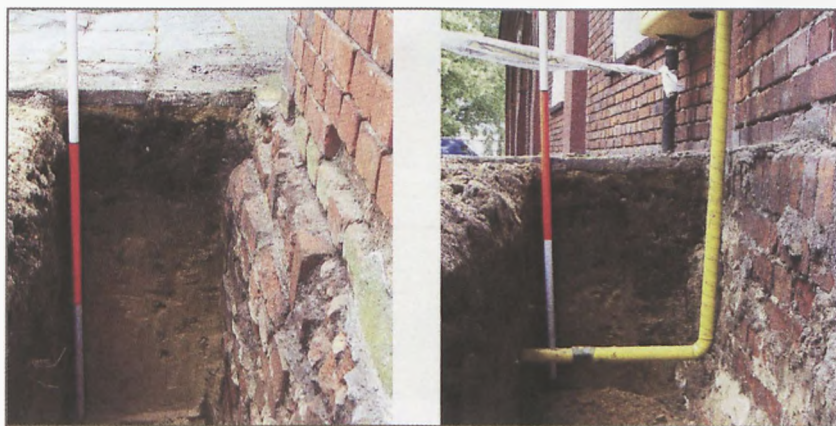
208. Wykopy ziemne przy fasadzie budynku brackiego. (Zbiory T. Stępnika)
