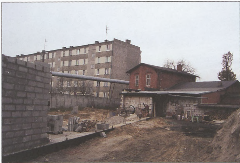
194. Stan budowy 25 metrowej strzelnicy do strzelania z broni krótkiej 22 XI 2008 r. (Zbiory autora)
