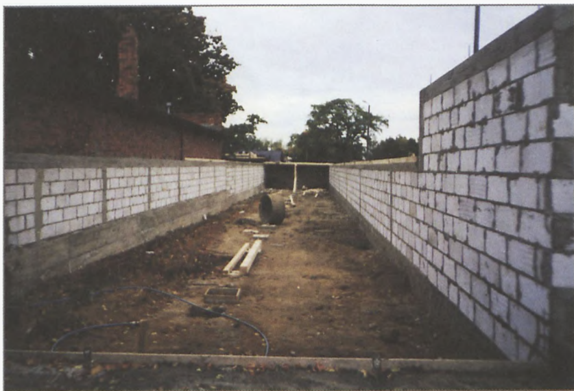
156. Budowa 50 m. automatycznej strzelnicy krytej – lipiec 2002 r. (Zbiory KBS)
