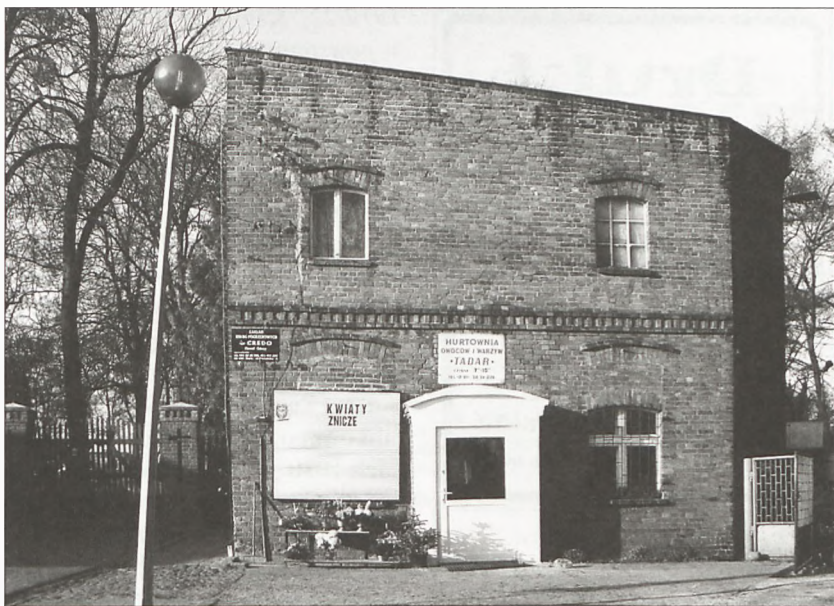
34. Budynek Drukarni Centralnej przy ulicy Cmentarnej w Śremie
