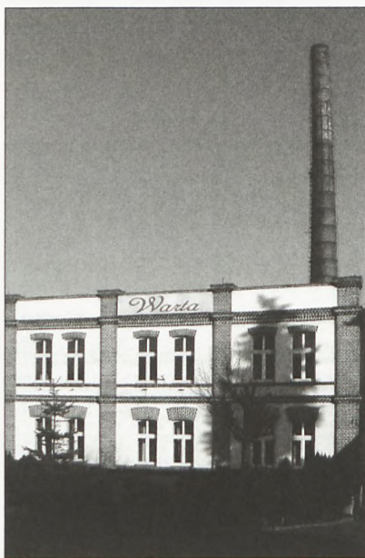
13. Budynek Drukarni Hermanna Schwantesa przy ulicy Mickiewicza 11, zbudowany w latach 90-tych XIX w. Od 1922 r. siedziba fabryki „Malto”. Obecnie spółdzielni Inwalidów „Warta”
