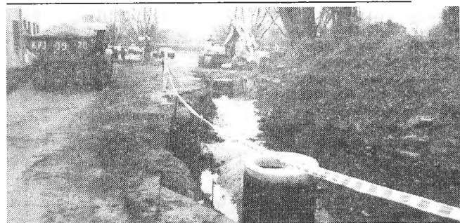
Rozpoczęła się przebudowa parkingu przy ul. św. Ducha w Jarocinie. Korytło Lipinki zostanie przykryte asfaltową kładką. Będzie też wybudowany wyjazd z parkingu na ul. Wodną
