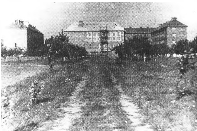
Widok budynków technikum w roku 1957, w czasie budowy sali gimnastycznej
