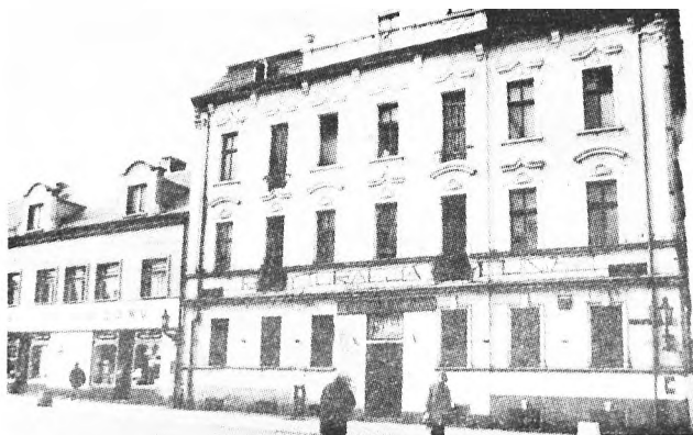
Jeszcze w tym roku rozpoczną się prace renowacyjne przy elewacji budynku byłego hotelu „Polonia”. Więcej na ten temat w następnym numerze „Gazety”
