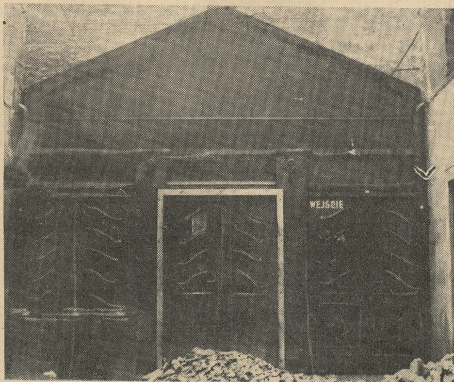
W domu przy ul. Wielkiej 19, w podwórzu, dokonuje się przebudowy budynku, w którym dawniej była fabryka galanterji. Budynek ten, za wiedzą właścicieli domów-Polaków, zamieniony ma być na siedzibę „Związku Żydów w Poznaniu“.
