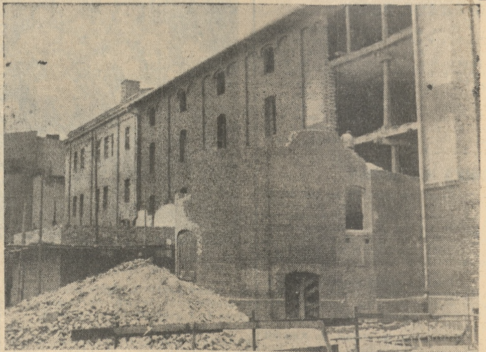
Widok na wykonane prace przy kościele św. Michała. Wielki budynek przystosowuje się do wymogów projektu budowlanego, widzimy rozbiórkę baszty okrągłej, na której był dzwon kościelny, dalej widoczne mury nowej zakrystji.
