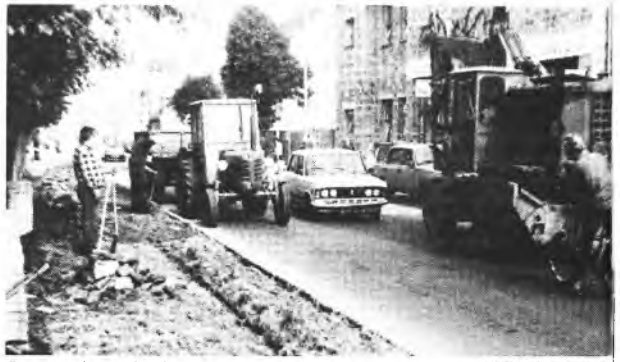
Prace na ul. Wrocławskiej
