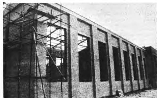
Rozbudowa szkoły w Kolniczkach.
