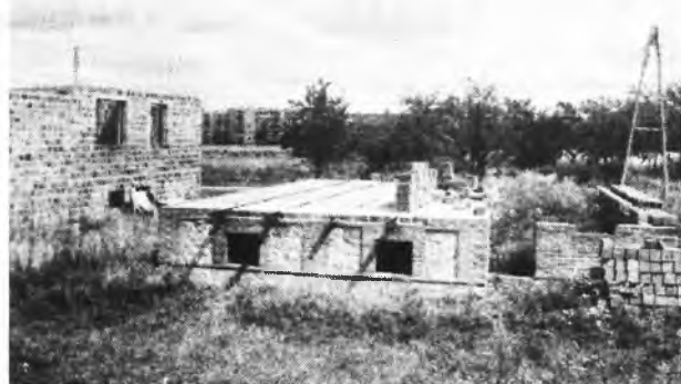
Kredyt może nie starczyć na wybudowanie fundamentów i piwnic FOTO Stachowiak
