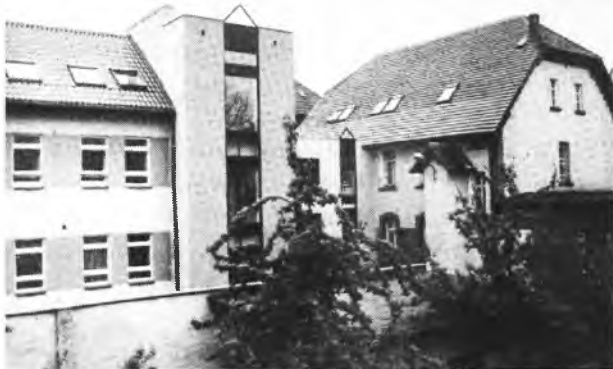
Nadbudowa budynków, przebudowa dachów płaskich na strome oraz adaptacja poddaszy, to jeden z bardziej opłacalnych sposobów uzyskania nowych mieszkań i pomieszczeń biurowych. Przykładem takiego rozwiązania jest budynek Urzędu Skarbowego w Jarocinie, który rozbudowano i zmodernizowano w latach 1993-1994. Projektantem i inwestorem zastępczym było Przedsiębiorstwo Wielobranżowe „KORYS”, generalnym wykonawcą - „REM - BUD” s.c. R. Grzebyszak, B. Wiatrowski.
