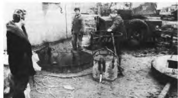
Montaż studni ściekowej na Ługach (z lewej: kierownik budowy - Teresa Kaliska z poznańskiej „HYDROBUDOWY - 9”) FOTO Stachowiak
