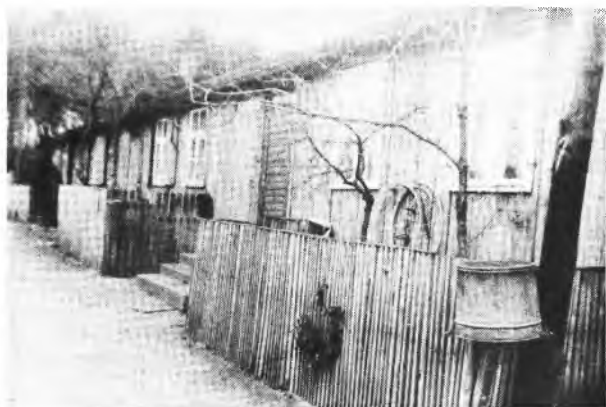
Baraki na ulicy Poznańskiej przeznaczone są do rozbiórki. Niestety, ich mieszkańcy nie mają się gdzie przeprowadzić. FOTO Stachowiak
