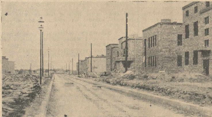
Budowa ul. Kasztelańskiej w nowym osiedlu
