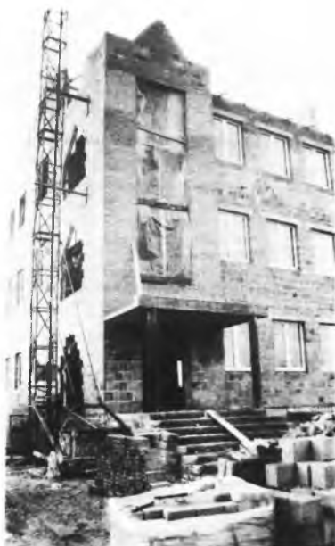
Ostatnia budowa „JARBUDU” - budynek Zakładu Energetycznego FOTO Stachowiak
