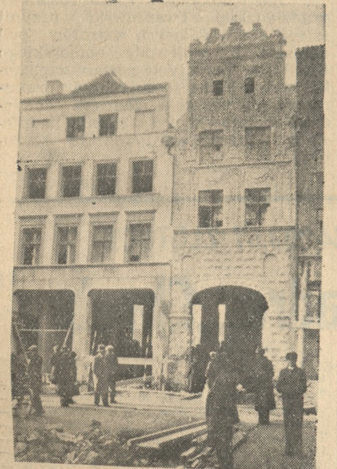
Zabytkowy dom barokowy w Toruniu z XVII w., zwany „Łukiem Cezara” i sąsiedni dom zabyt. z XVI w. są już przebudowane. Pod domem przy ul. Piekary 35 wybito 2 tunele, przez które będzie przechodziła linia tramwajowa i jezdnia. (z)
