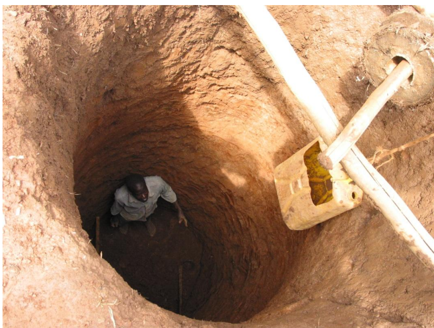
Fot.7 Pierwszy etap budowy latryny - wykopanie głębokiego dołu, który następnie zostanie przykryty drewnem i gliną, z pozostawieniem niewielkiego otworu.
