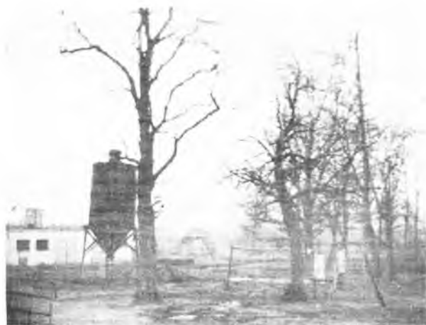
Zdewastowana część parku
