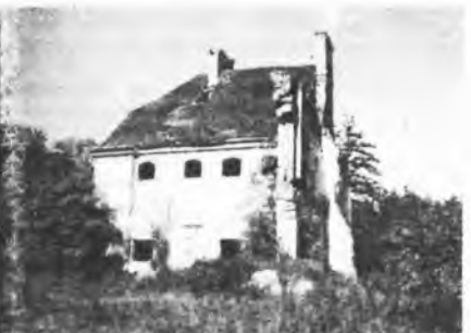
Pozostałość dworu (stan obecny) Fot. Leszek Bajda
