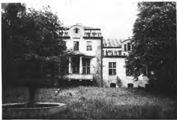
Pałac w Słupii, stan obecny
