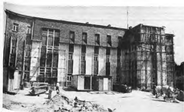
Prace przy elewacji nowej centrali i siedziby Rejonu Telekomunikacji w Jarocinie zbliżają się do końca (fot. J. Stachowiak)
