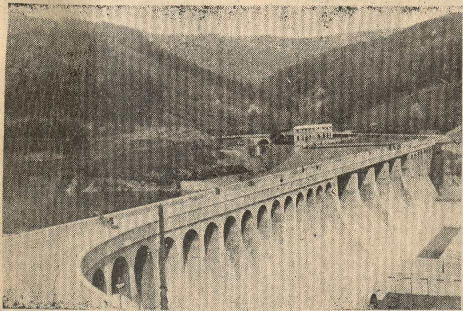
Zapora wodna na Sole w Porąbce
