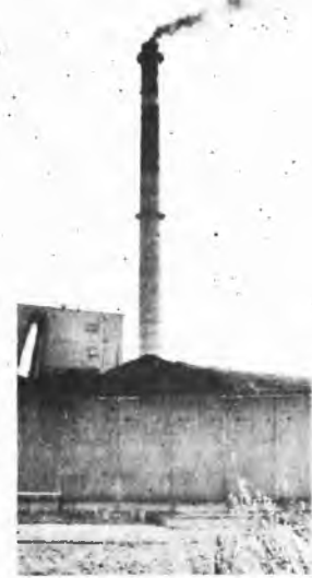
Kotłownia - ul. Węglowa (fot. J. Zwierzki)
