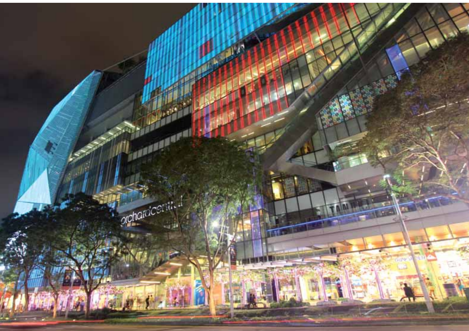
Dom handlowy Orchard Central, projektu firmy DP Architects, oddany do użytku w 2009 roku. Charakterystycznym elementem budynku są zewnętrzne schody ruchome oraz stale zmieniające się kolory oświetlenia.
