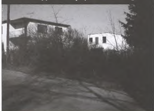
Zarośnięty chodnik przy ul. Berwińskiego
