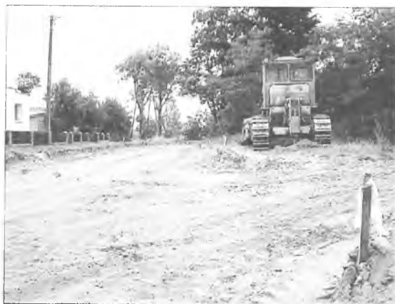
Budowa ulicy Słonecznej w Nowym Mieście została w połowie sfinansowana z funduszu SAPARD
