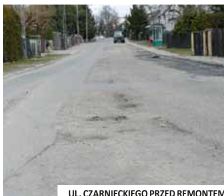
UL. CZARNECKIEGO PRZED REMONTEM
