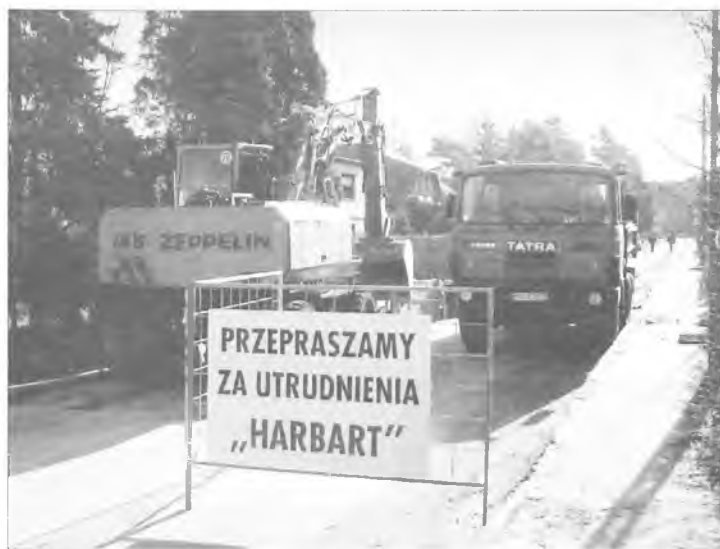
Prace przy ul. Poznańskiej
