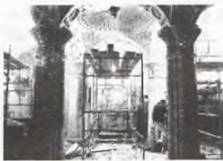
W trakcie remontu — fot. Jerzy Miecznikowski
