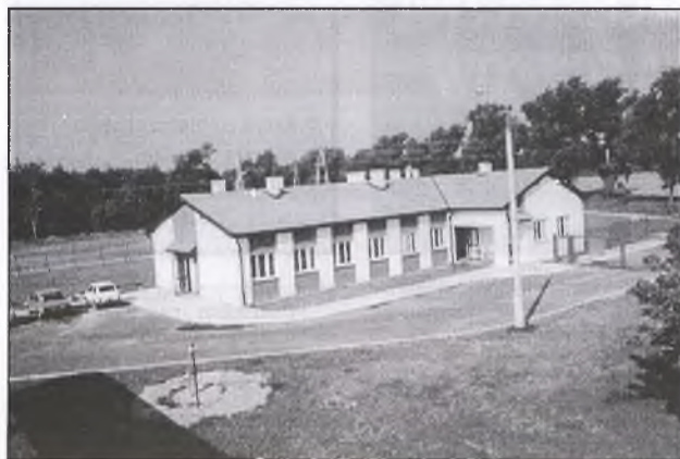
Budynek zaplecza technicznego
