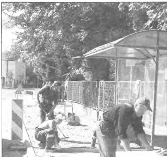
Kanalizacja sanitarna na ul. Dworcowej
