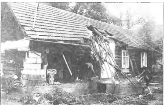
Zniszczony dom mieszkalny w Korzennej
