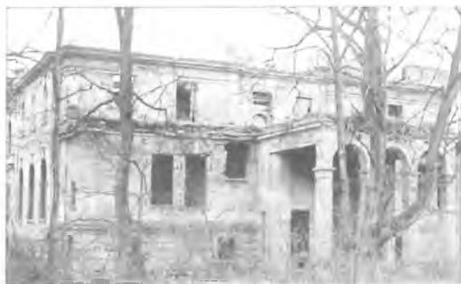
Pałac w Dębnie - stan obecny - fot. P. Kwieciński
