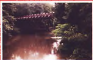
Zniszczony most kolejowy przez Gwotę koło Jastrowia
