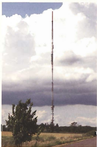
Góra, maszt Radiowo-Telewizyjnego Centrum Nadawczego
