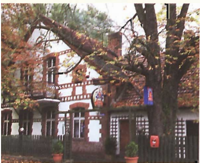
Radzewice, restauracja Nadwarciańska
