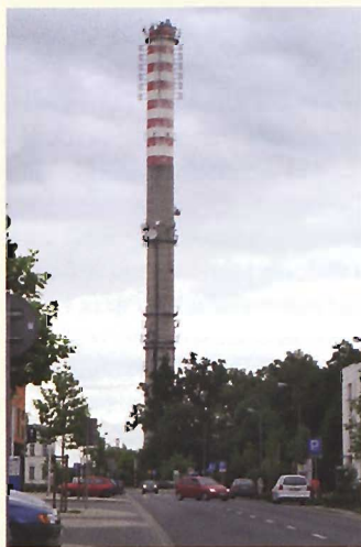
Mosina, komin dawnej fabryki mebli
