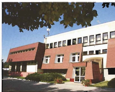
Budynek firmy Danko Hodowla Roślin
