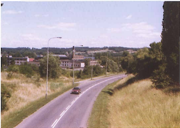
Chodzież. Obwodnica szosy nr 11, w głębi dawna fabryka porcelitu
