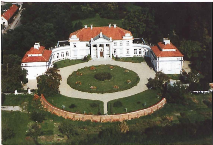
5. Pałac w Śmielowie
