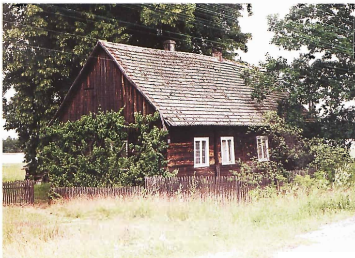
Zabytkowy dom drewniany w Borui Kościelnej
