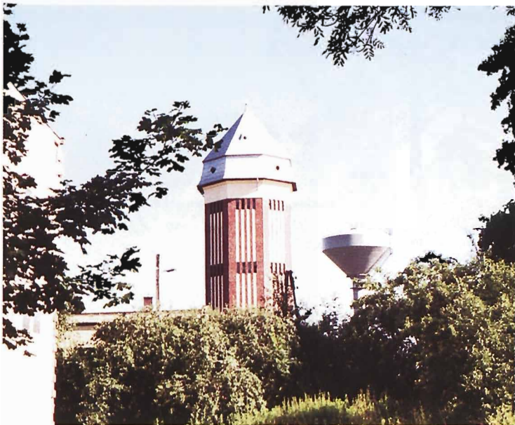
Stara i nowa wieża wodociągowa
