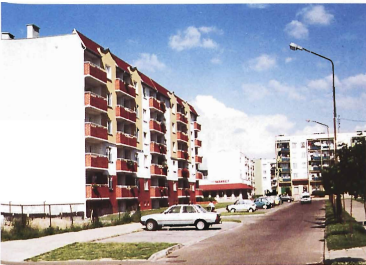
Fragment osiedla Północ
