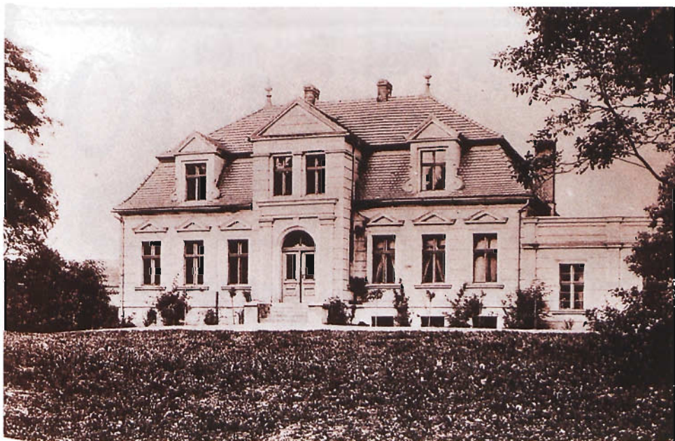
Dwór przed rozbudową. Fotografia sprzed 1912 r. zamieszczona w książce L. Durczykewicza Dwory polskie w Wielkim Księstwie Poznańskim
