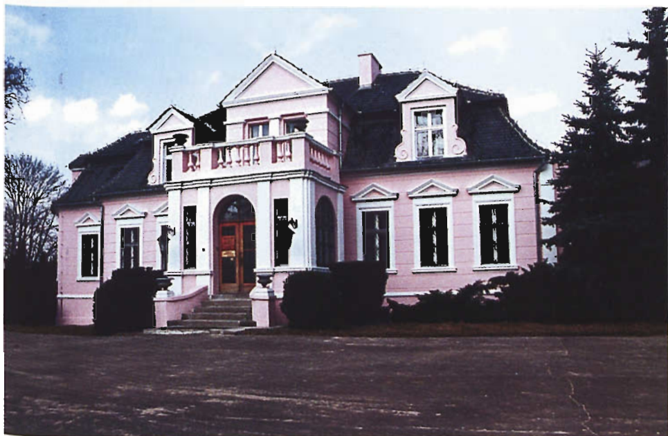
Dwór – elewacja frontowa, stan z 1996 r. Fot. J. Miecznikowski
