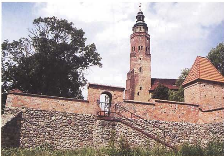
Wschowa. Fragment murów obronnych i wieża kościoła farnego
