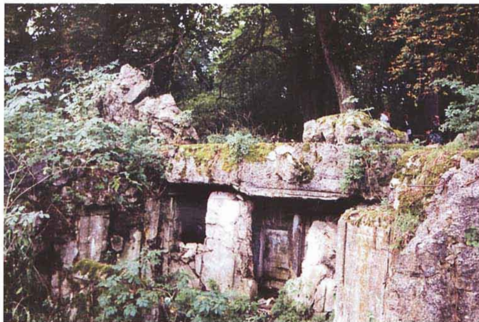
57. Ruiny schronów pod Zdbicami (rozdział 150)
