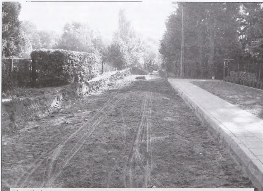
Ulica Mickiewicza przygotowana do wykonania podbudowy tłuczniowej
