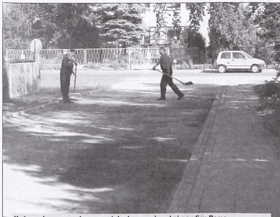
Kończą się prace związane z ułożeniem nawierzchni na ulicy Bema
