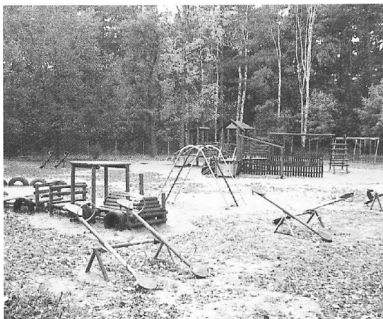
Pozostałe przedszkola remontowano i wykonano przy nich place zabaw
