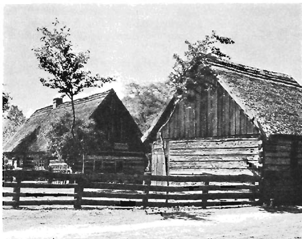
Blockhausdorf Kaza im Grenzgebiet des Kreises Schwerin (M.)
