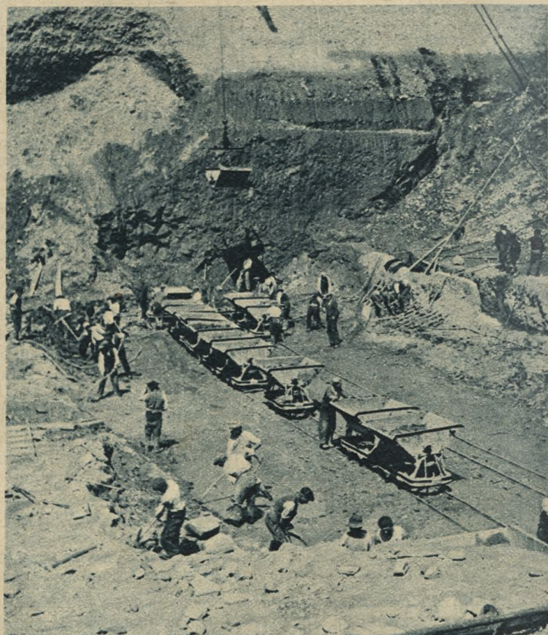
Wykop pod fundament tamy. Fundament położony 20 metrów poniżej powierzchni wody.
