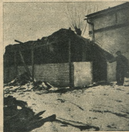
P. Jankowski z Radzewa zbudował sobie silos z drzwiami i z cegły cementowej. Długość 6 m, szerokość 3 m, głębokość 2 m, grubość 40 cm.
