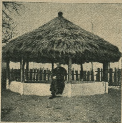
P. Jaskuła z Błaziejewa cieszy się ze swego glinianego dzieła — silosu o średnicy 4,20 m, głębokości 2 m (1 m w ziemi — 1 m nad ziemią) grubości 30 cm i o słupkach wysokich od ziemi 1,80 m.
